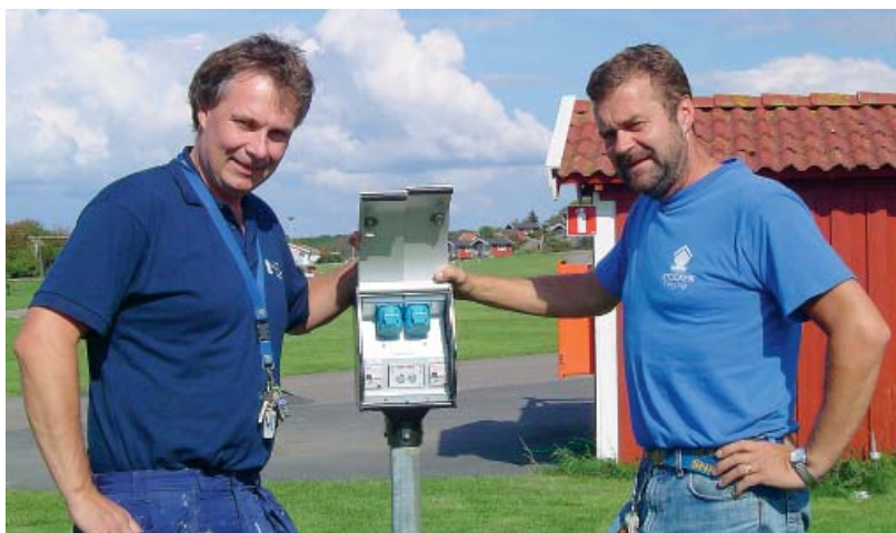
Freddy Alm och Roger Gustafsson inspekterar en av campingplatsens elstolpar, där den nya insatsen installeras.
