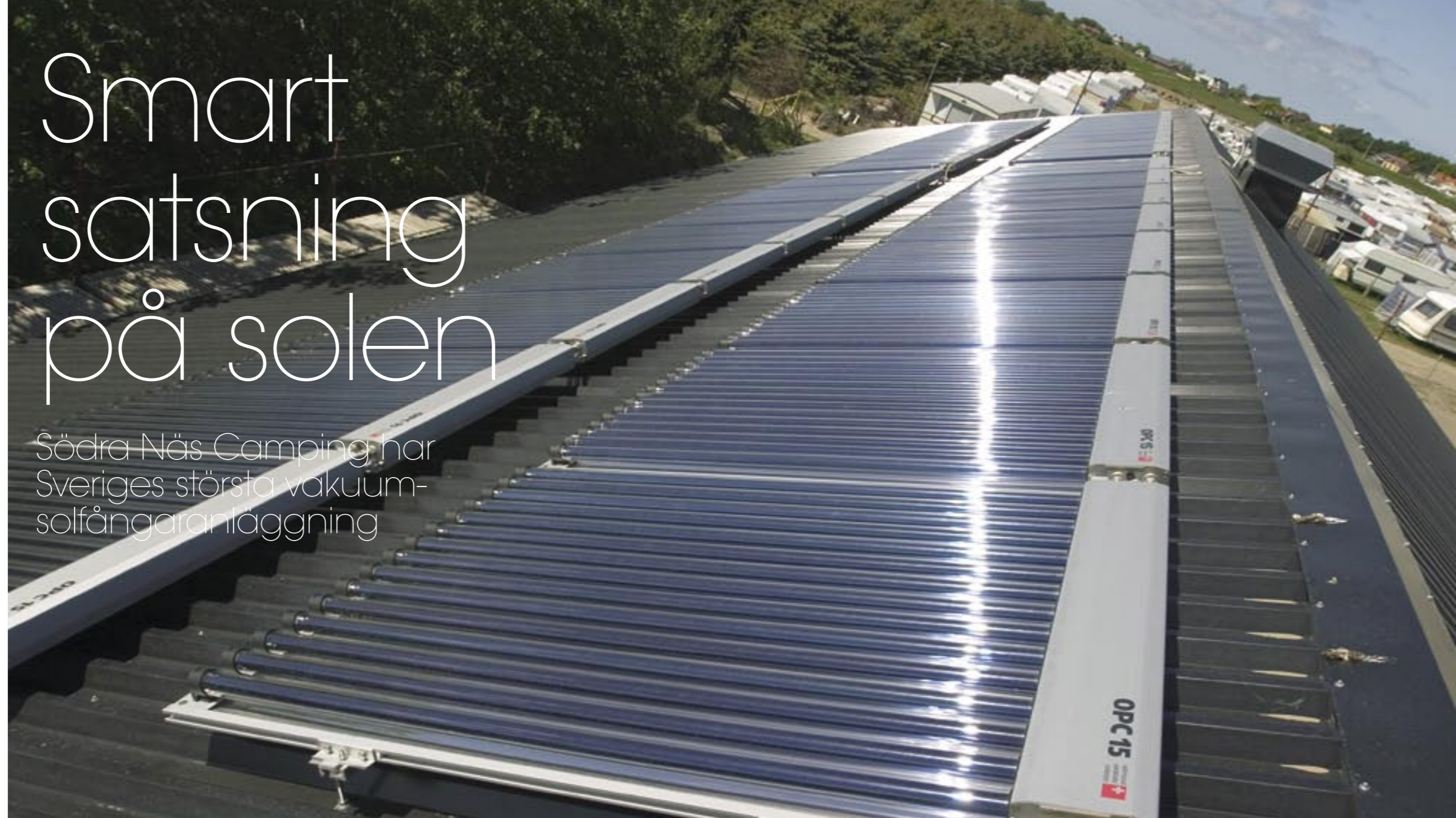
Sveriges största vakuumsolfångaranläggning värmer allt varmvatten och håller värmen i det nybyggda servicehuset på Södra Näs Camping. Foto: EURONOM AB
